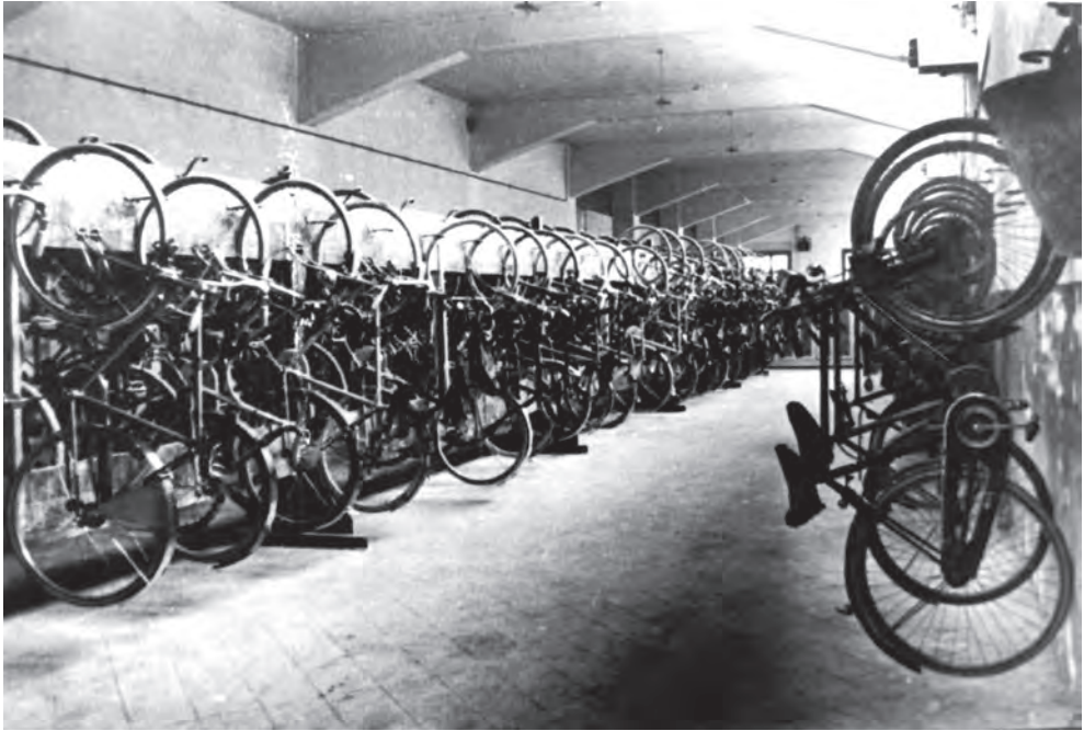
Officine Meccaniche Ferroviarie Pistoiesi, veduta dei locali interni (ASSG, V, 1)
